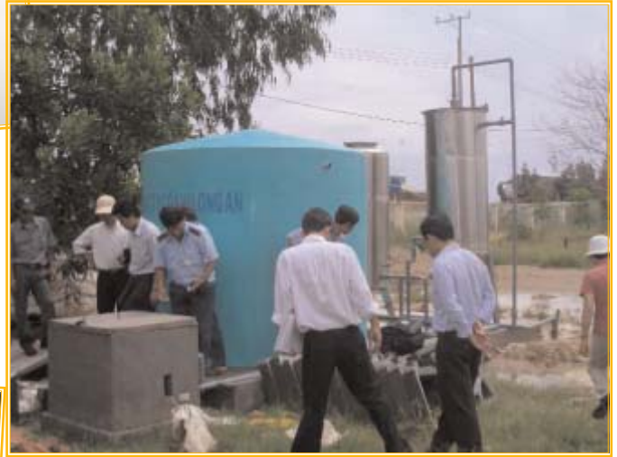
Kiểm tra chất lượng hệ thống nước
