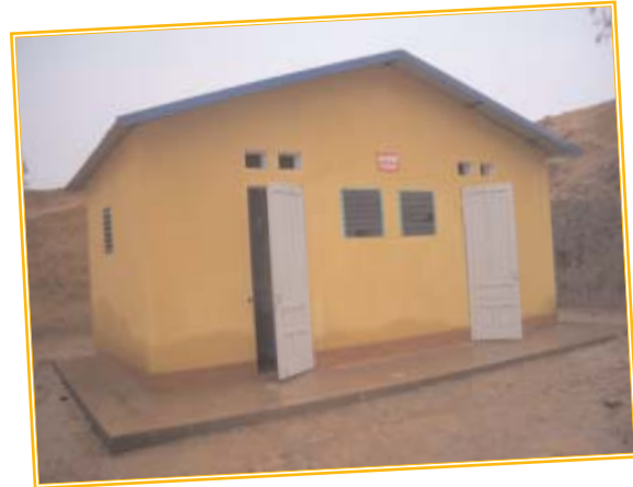
Nhà vệ sinh môi xây tại tỉnh Thái Nguyên
